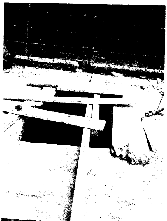
INSTALACION DEL POZO A TIERRA
