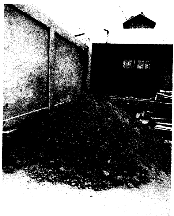
RELLENO DE TIERRA NATURAL PARA EL POZO A TIERRA
