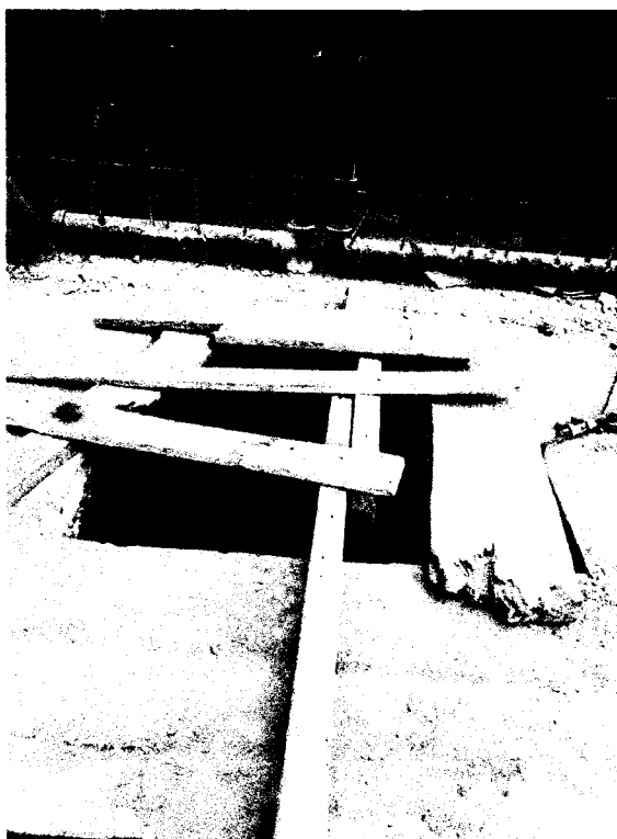
INSTALACION DEL POZO A TIERRA
