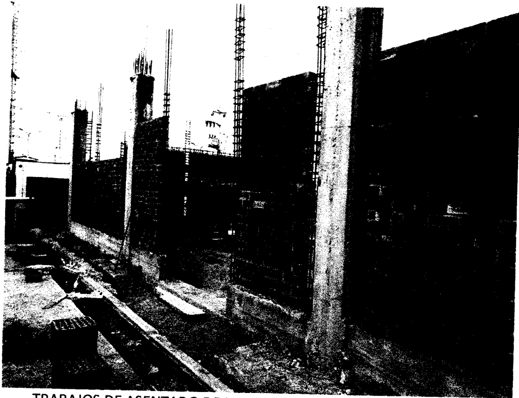
TRABAJOS DE ASENTADO DE LADRILLO EN SALA DE TAREAS PREVIAS
