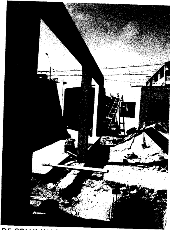
TRABAJOS DE COLUMNAS Y VIGAS DE PLANTA DE TRATAMIENTO
